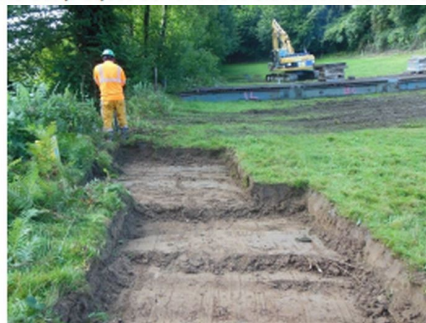
Station d'espèce après décapage de la couche superficielle de terre (Source GERA)
