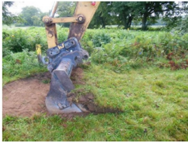
Les plaques de terre seront enlevées avec un godet sans dent (source GERA)
